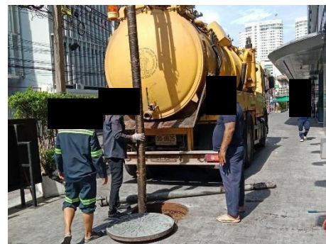
ภาพที่ 2.2-14 การสูบน้ำกากตะกอน จากระบบบำบัดน้ำเสีย
