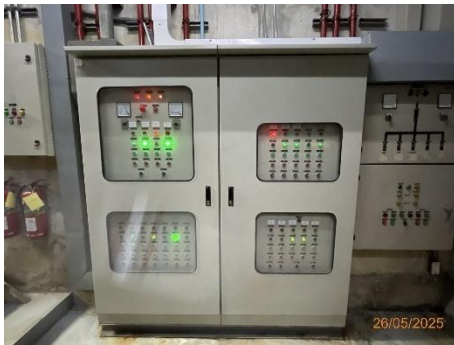
ภาพที่ 2.2-15 การติดตั้งมิเตอร์ไฟฟ้าสำหรับ ระบบบำบัดน้ำเสีย
