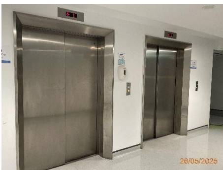
ภาพที่ 2.2-37 ลิฟต์ดับเพลิง
