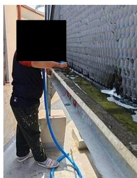
ภาพที่ 2.2-43 การทำความสะอาด และกำจัดตะกอนในท่อฝังเย็น
