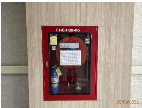
ภาพที่ 2.2-35 ตู้เก็บสายฉีดน้ำดับเพลิง พร้อมอุปกรณ์ (Fire Hose Cabinet : FHC)
