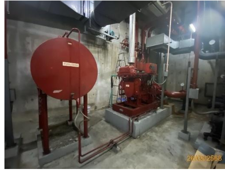
ภาพที่ 2.2-33 เครื่องสูบน้ำดับเพลิง (Fire Pump)
