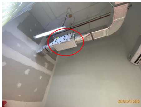
ภาพที่ 2.2-27 การติดตั้ง UV LAMP
