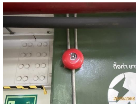
ภาพที่ 2.2-39 เครื่องแจ้งเหตุโดยใช้มือดึง (Fire Alarm Manual Station) และกริ่งสัญญาณเตือนภัย (Alarm Bell)
