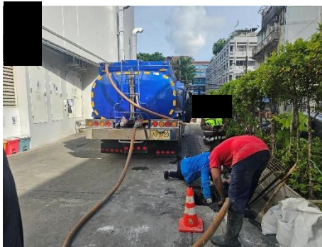
ภาพที่ 2.2-22 การขุดลอกท่อระบายน้ำ
