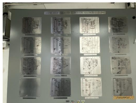
ภาพที่ 2.2-38 แผงควบคุม (Fire Alarm Control Panel : FCP)
